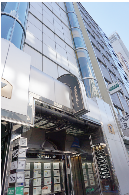
▼イワキビル(横須賀第6ビル)
